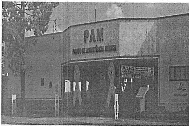
Estrutura física danificada
