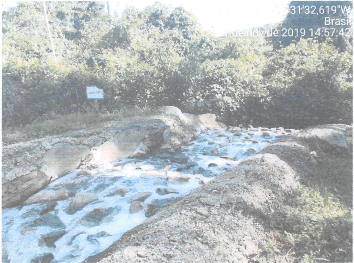
Foto 06: Vista do emissário final do esgoto tratado
