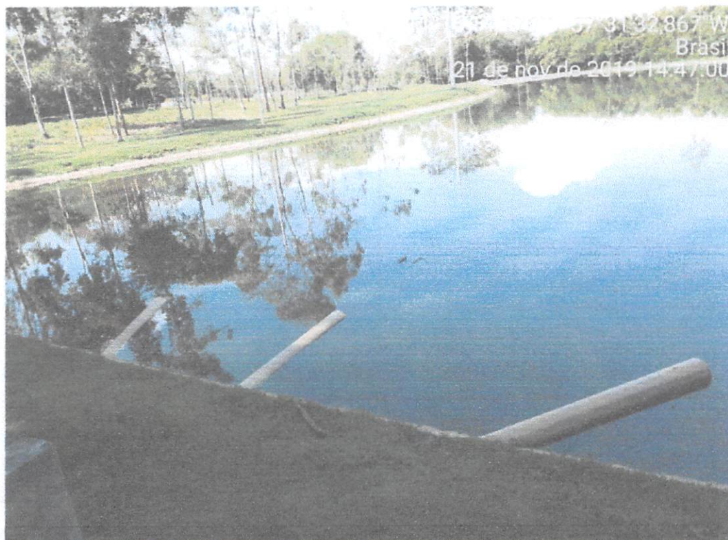
Foto 05: Vista da lagoa de polimento
