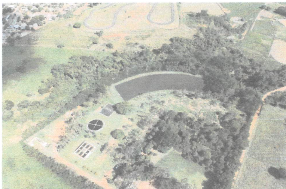
Foto 01: Vista aérea (Drone DjiSpark) da ETE Córrego dos Saltos
