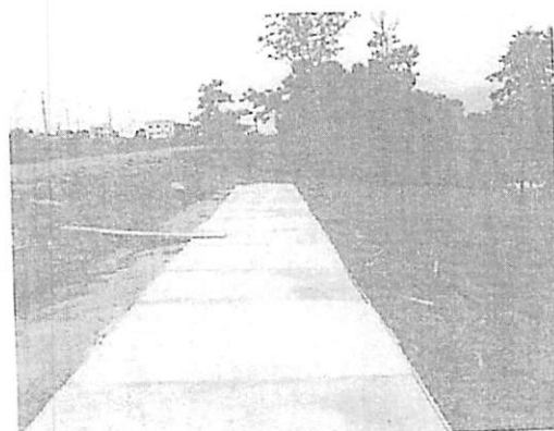
Imagem de execução de passeios no entorno da APP em fase de execução
