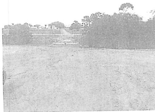
Imagens serviços primários (terraplenagem - base e sub-base), danificados. Serviços de sub-base e base sendo prejudicada pela chuva.
