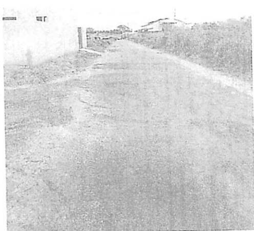
Imagem de execução da capa asfáltica (imprimação), estando estes serviços já comprometidos devido à paralisação e não conclusão dos serviços e o tráfego de veículos.
