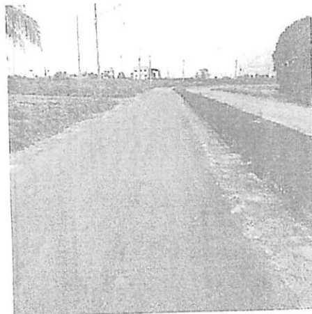
Imagem da imprimação danificada, surgimento de patologias na camada de base já executada
