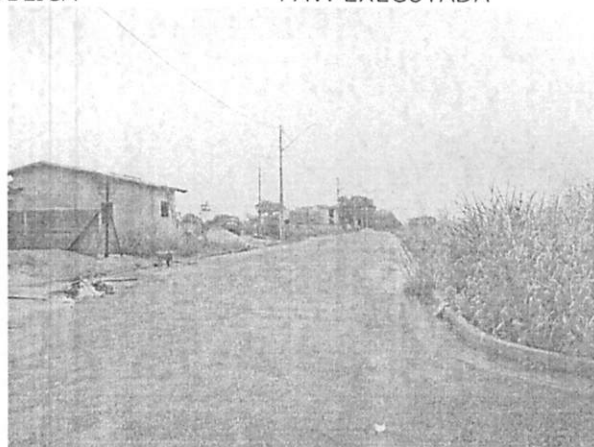
MEIO-FIO E SARJETA
