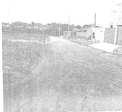
Imagem de execução da capa asfáltica (imprimação), estando estes serviços já comprometidos devido à paralisação e não conclusão dos serviços e o tráfego de veículos.
