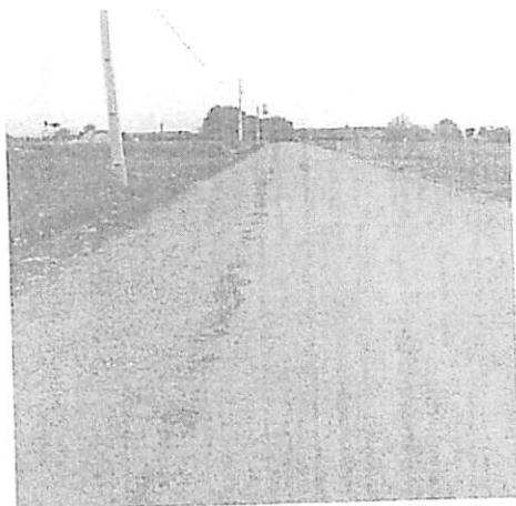
Imagem da imprimação danificada, surgimento de patologias na camada de base já executada
