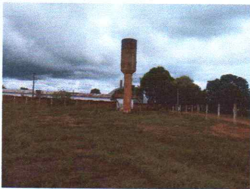
Reservatório tipo taça desativado
