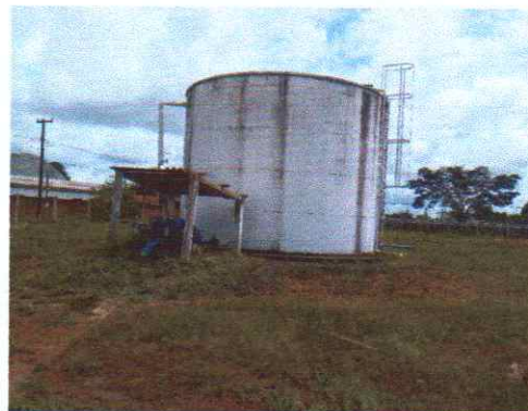
Reservatório central ativo 200m 3
