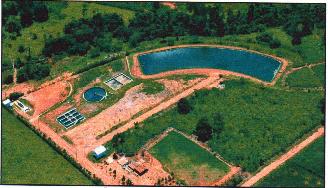
Imagem 45 - Vista panorâmica da Estação de Tratamento de Esgoto – ETE 01.
