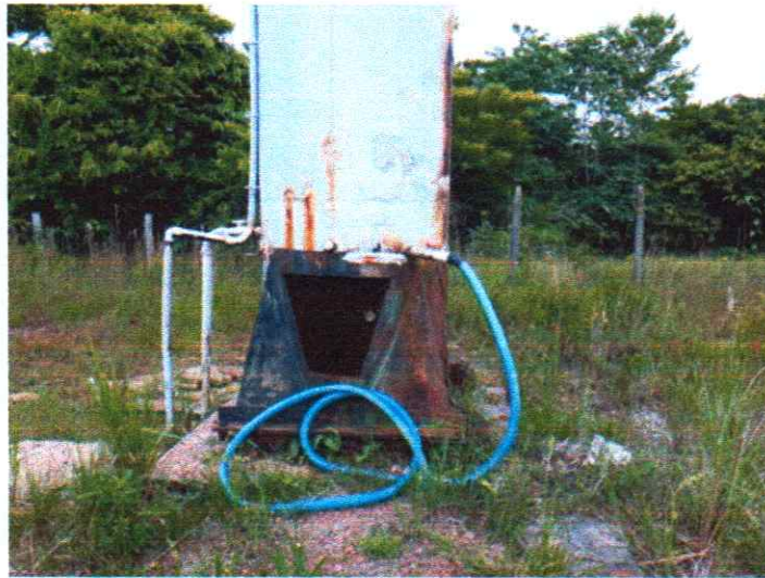
Reservatório elevado do Distrito de Águas Claras
