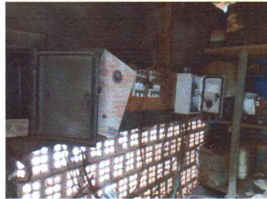
instalação do quadro de comando P2 e P3
