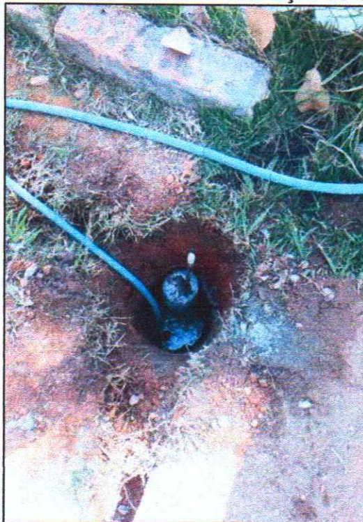
Imagem 54 e 55 - Obras de instalação do SPDA.
