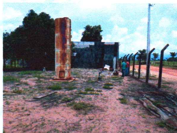
Vista geral captação
