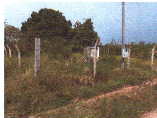
Área P4, com mato situação inadequada
