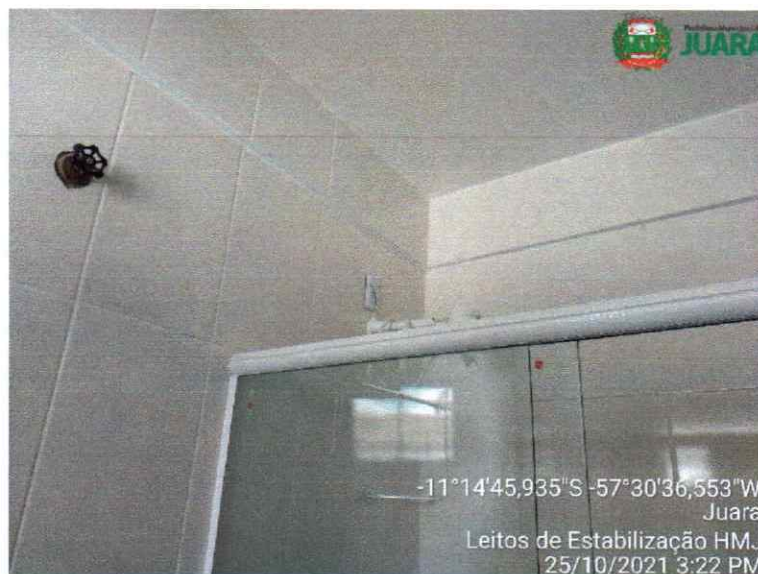
Figura 7: Chuveiros com Falta de Instalação Elétrica
