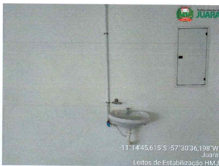
Figura 10: Falta de acabamento na hidráulica e pia torta.
