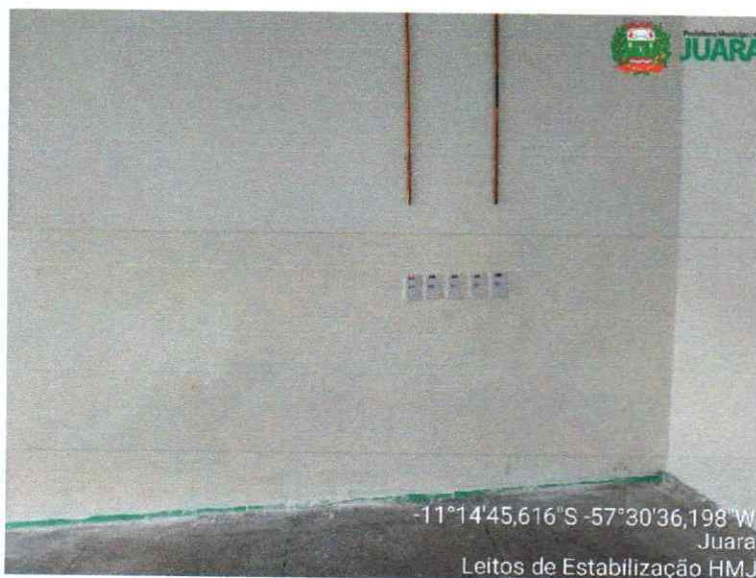
Figura 20: Pintura da parede manchada.
