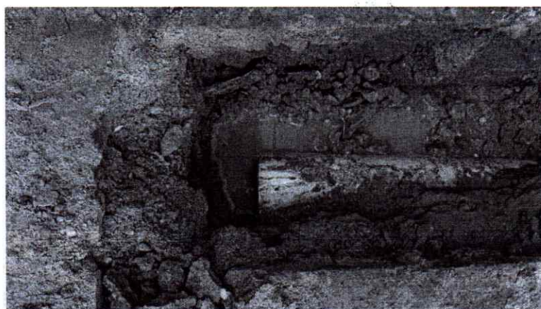
Foto 05 - Um dos pontos em que a tubulação não tinha sido finalizada pela Empresa anterior.
