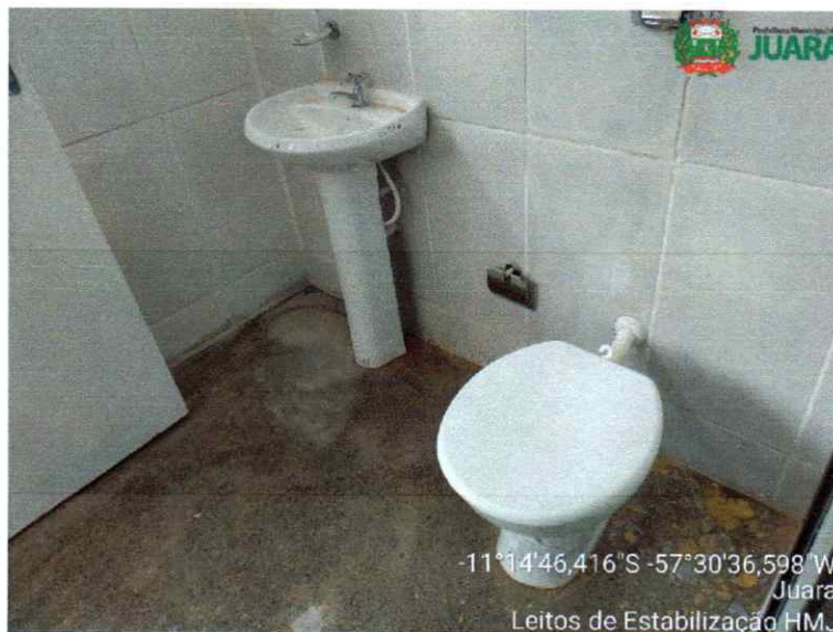
Figura 29: Parede apresentando umidade.
