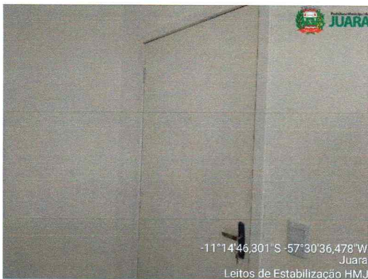
Figura 2: Portas com apenas uma demão de pintura e que não apresentam lixamento
