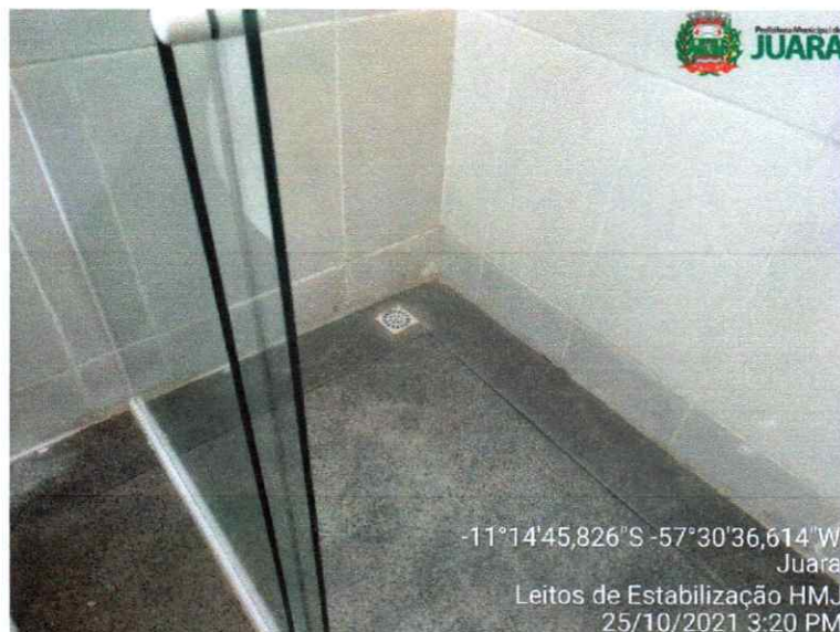
Figura 6: Falha no Escoamento dos Ralos
