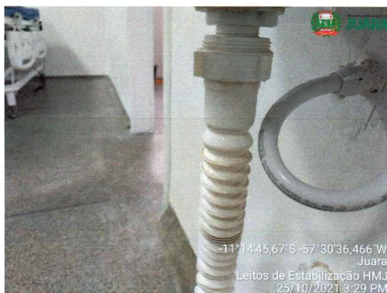
Figura 9: Vazamento no Sifão
