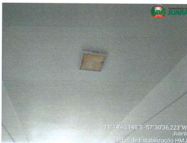
Figura 18: Lâmpadas com infiltração na laje.
