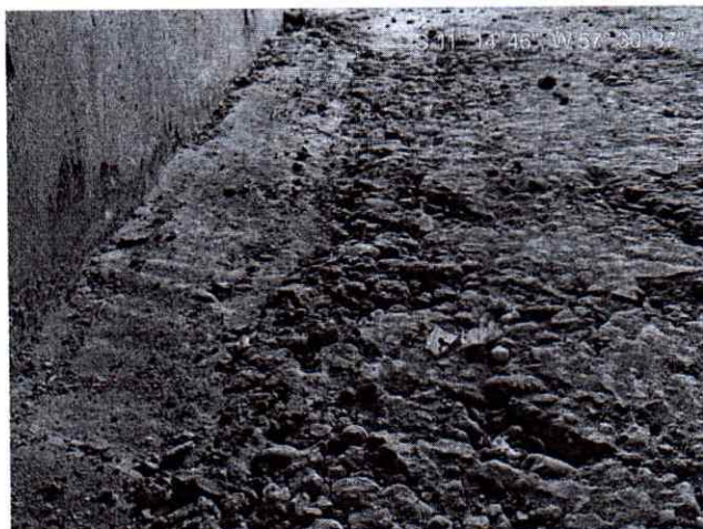
Foto 01 - Contrapiso deixado pela Empresa anterior em péssimas condições.
