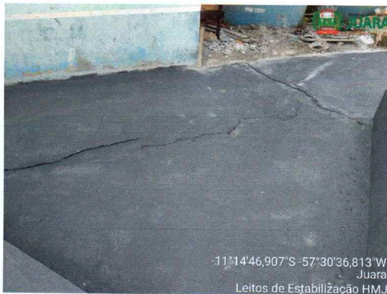
Figura 23: Trinca da calçada do estacionamento.
