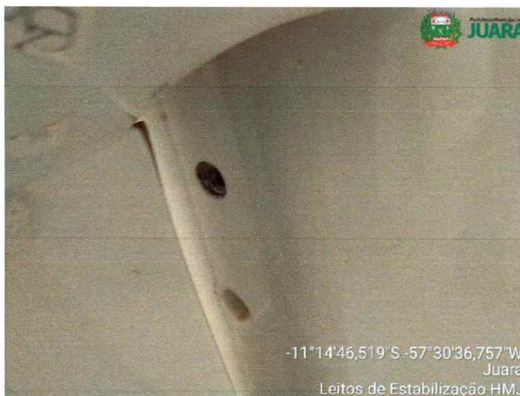
Figura 7: Pia desconectada das instalações hidráulicas e sanitárias
