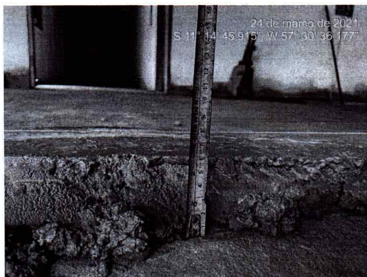
Foto 04 - Contrapiso executado pela Empresa Hebrom, em alguns pontos chegou a 6 cm.
