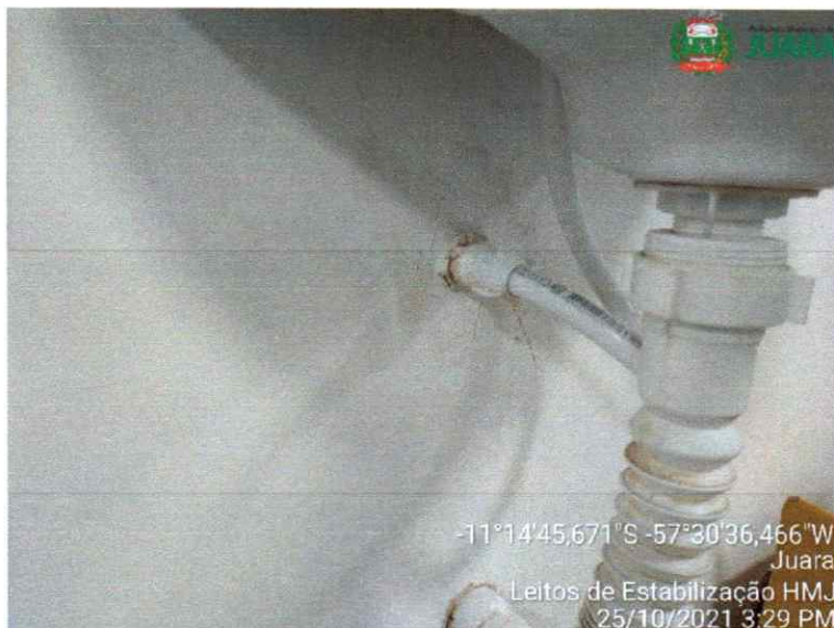
Figura 10: Vazamento na Parede e Mal Acabamento
