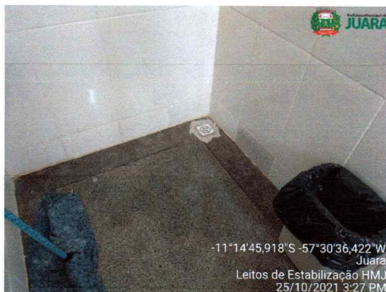
Figura 12: Falta de Acabamento do Ralo e do Piso Granilite
