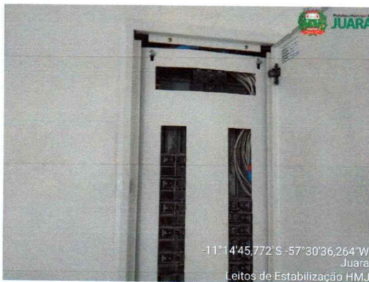
Figura 19: Quadros de Distribuição sem fechamento interno nem etiqueta dos circuitos.
