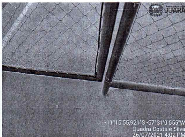
Figura 9: Falhas na pintura da tela e tubos do alambrado
