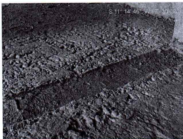
Foto 02 - Contrapiso deixado pela Empresa anterior em péssimas condições.
