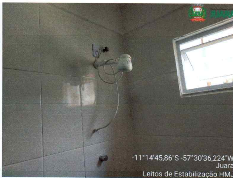
Figura 17: Chuveiros sem instalação elétrica.
