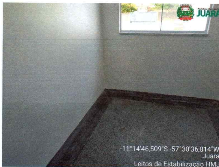
Figura 26: Falta de resina no piso granilite
