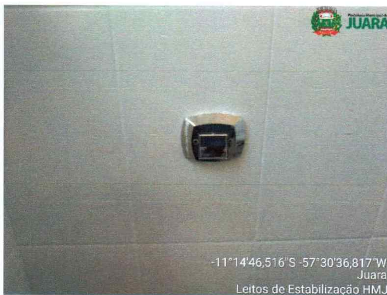
Figura 14: Descarga enroscada.
