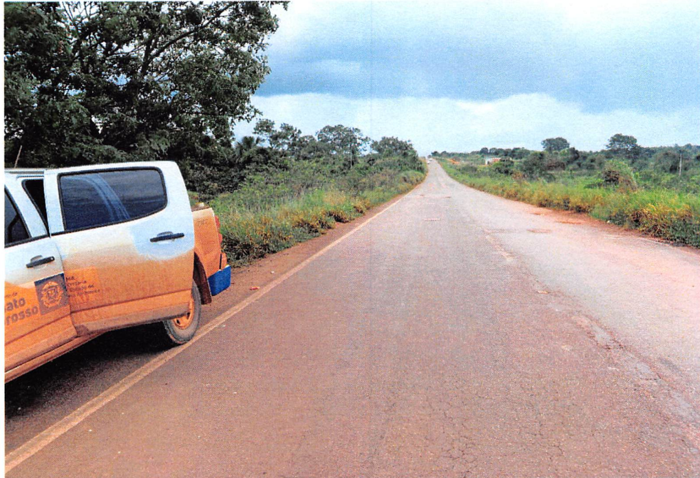
Foto 04: Vista da MT 220 (ponte do Córrego Água Boa)
