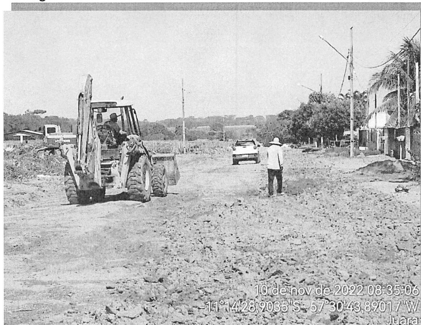
Imagem 01 – Obra do contrato 226/22 no dia 10/11/2022
