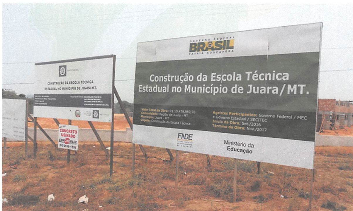
Placa de obra da Construção de Escola Técnica Estadual Juara-MT.
