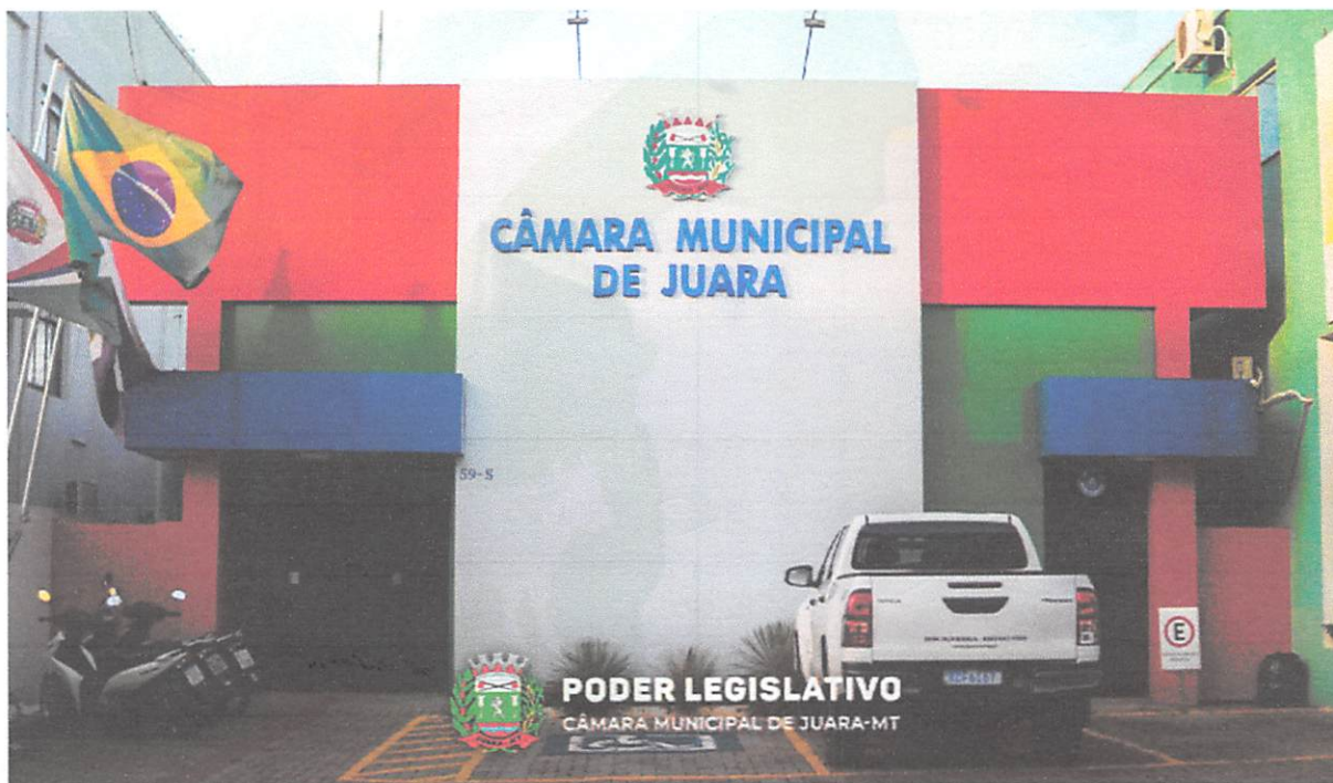
Fachada atual da Câmara Municipal
