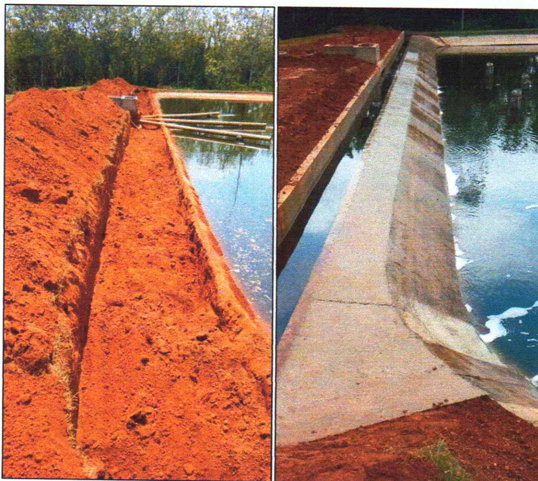
Imagem 44 - Mudança na lagoa de esgoto com implantação da calha, melhorando a distribuição e oxigenação. Ano: 2018.
