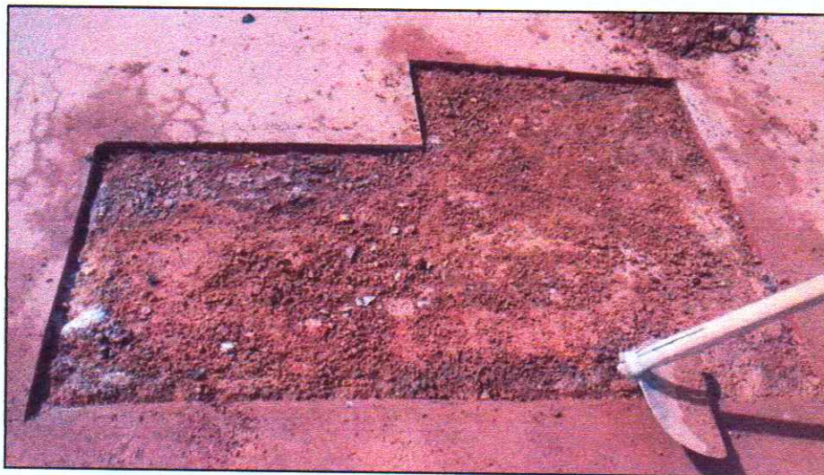
Imagem 50 - Demonstração do procedimento de reposição asfáltica.
