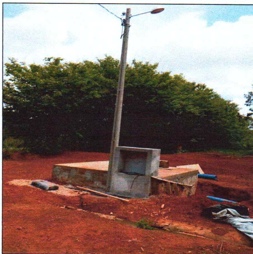
Imagem 37 - Obras do Sistema de Esgotamento Sanitário. Ano: 2014.
