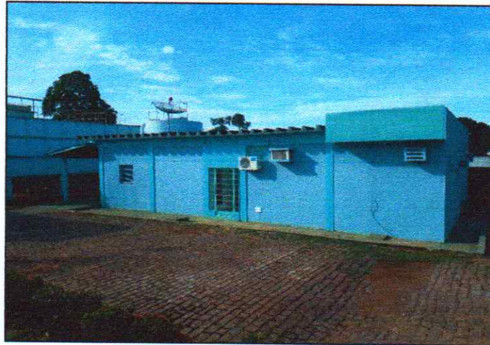
Imagem 21 - Vista externa do Laboratório – 2017.
