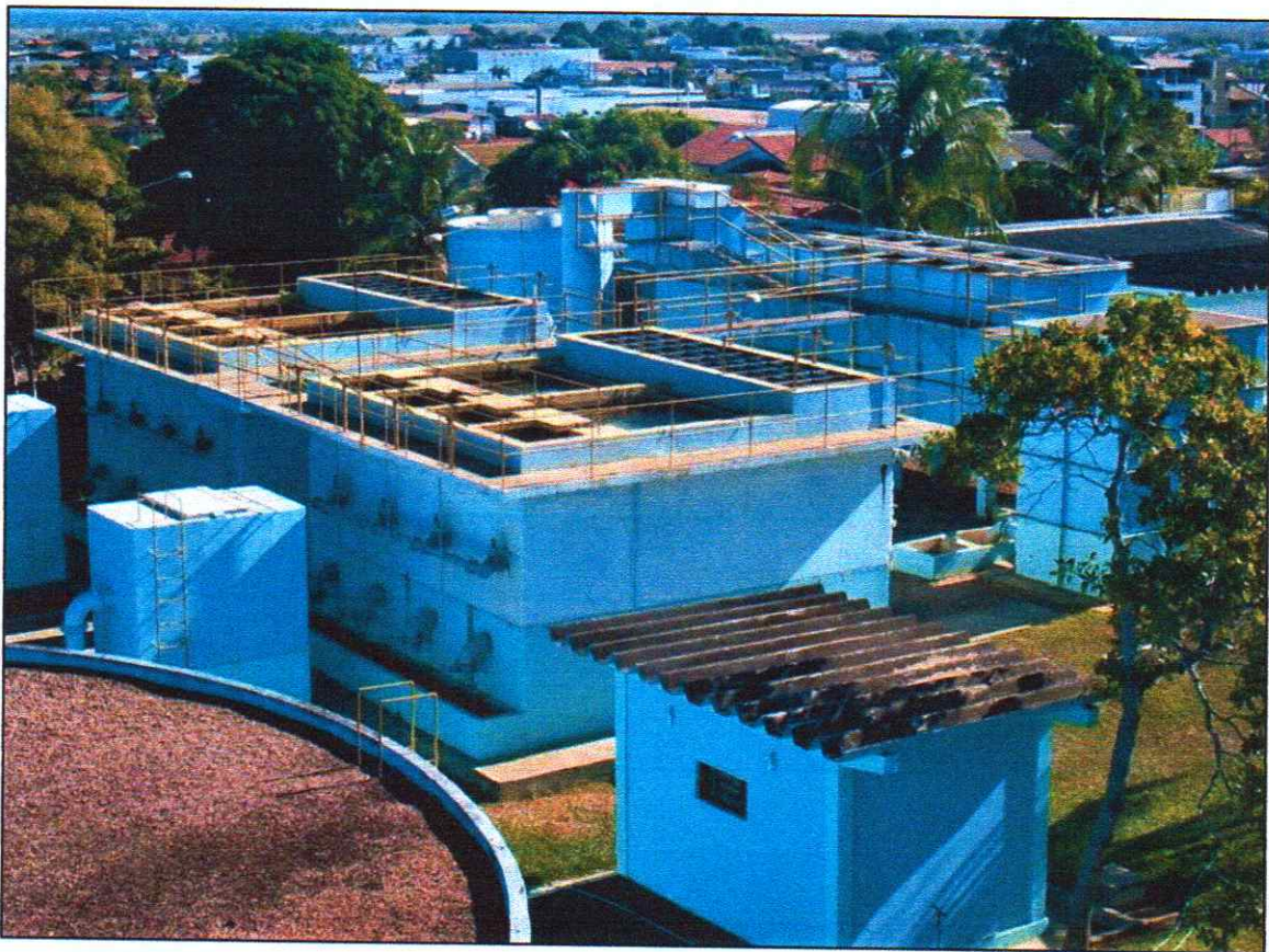
Imagem 29 - Vista do Sistema de Tratamento de Água na sede da Concessionária.
