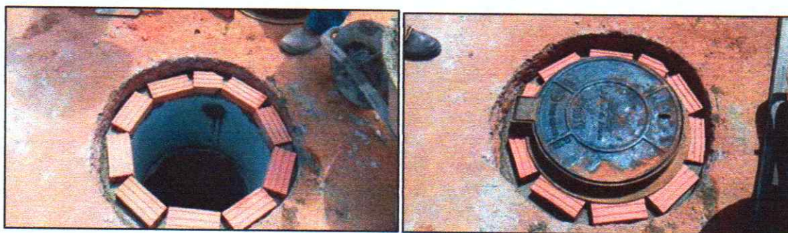
Imagem 43 - Elevação de poços de visita. Ano: 2018
