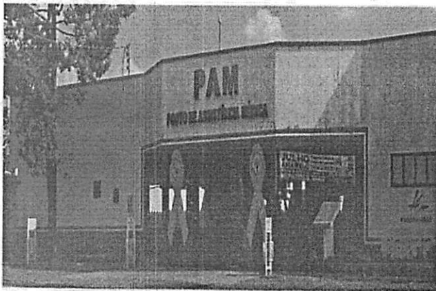
Estrutura física danificada
